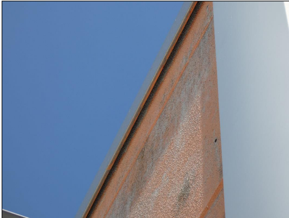
Bild 1: TO 1 Spalt zwischen Traufabschluss und Fassade
