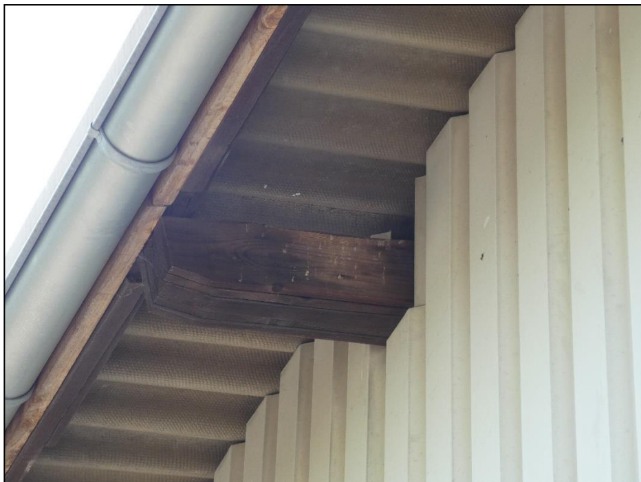
Bild 6: TO 3 Öffnung und Kots Spuren an Sparren
